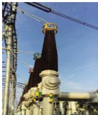
图 1 A 相出线套管
